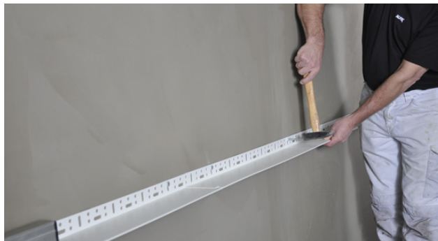
Montering av Alfix Startvinkel Flex
