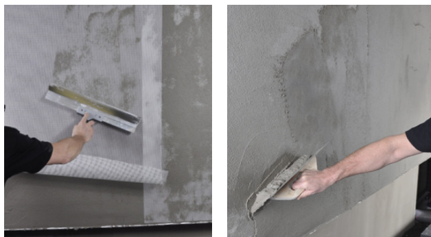
Montering av nät med minst 10 cm överlappning och påföring av heltäckande skikt Alfix DuraPuds 810
