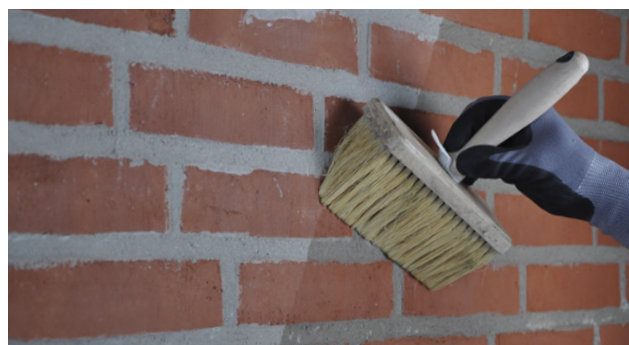
Förvattning av vägg
