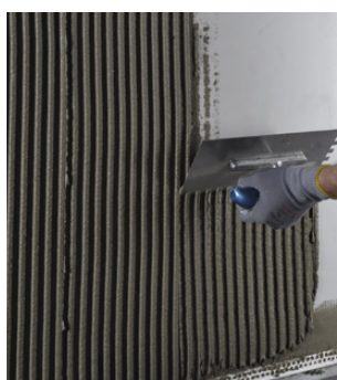
Påföring av DuraPuds 710/810 med tandspackel
