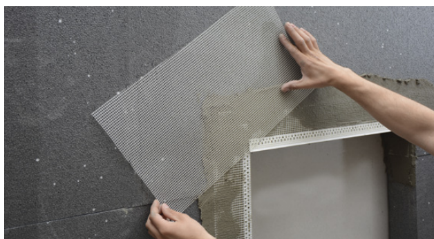
Inpassning av armeringsnät vid fönster
