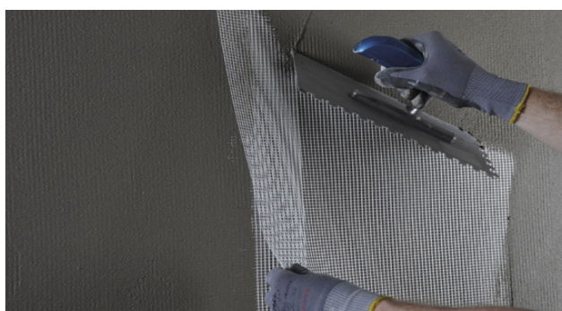
Montering av nät med minst 10 cm överlappning
