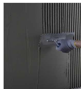
Påföring av DuraPuds 710/810 med tandspackel
