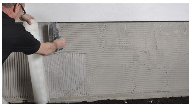
Montering av armeringsnät i Alfix DuraPuds 615
