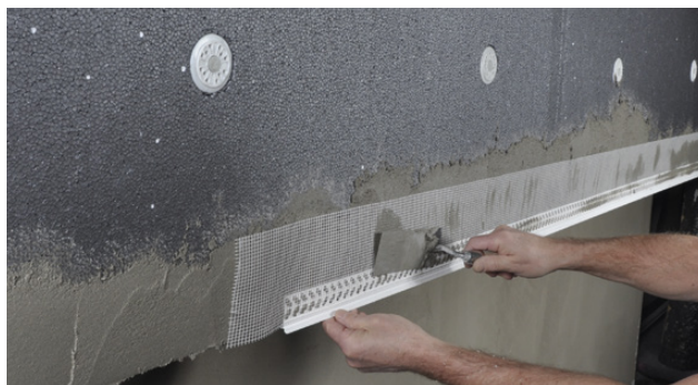
Montering av Alfix Bottenlist Flex
