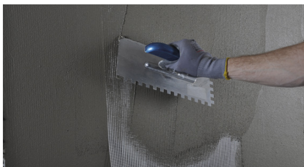
Glättning av nät med slätt stålspackel
