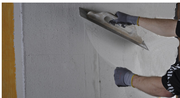
Montering av nät med minst 10 cm överlappning
