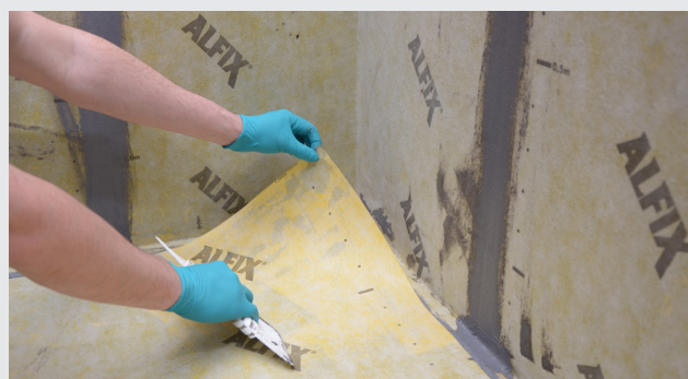
Montering av våtrumsmatta på golv
