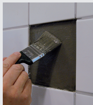
Tätningsmassan påförs underlaget och plattan monteras
