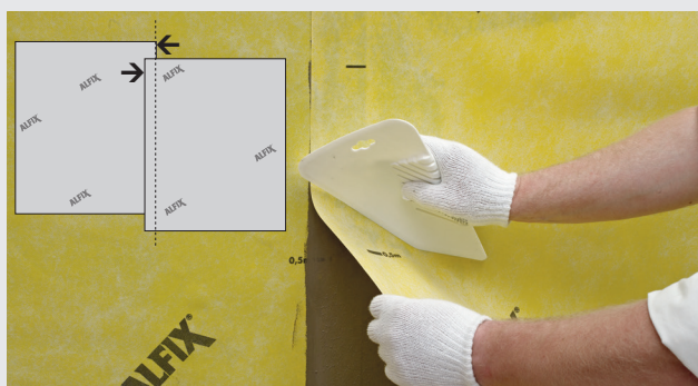
Montering av våd omlott vid skarv
