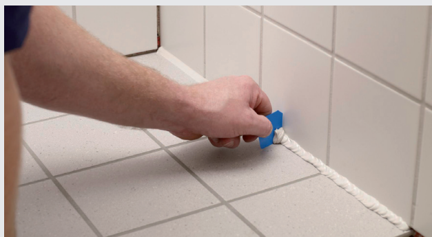
Överskjutande Alfix Silicon skrapas bort
