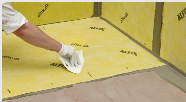
Montering av våd på golv
