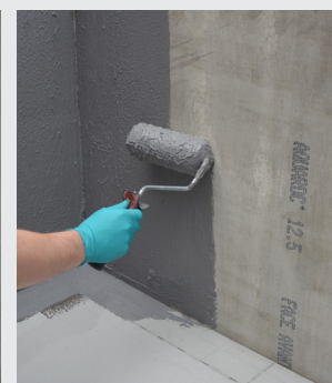
Påföring av tätningsmassa
