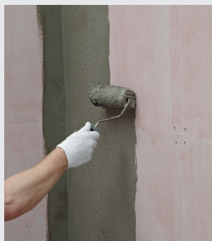
Påföring av tätningsmassa
