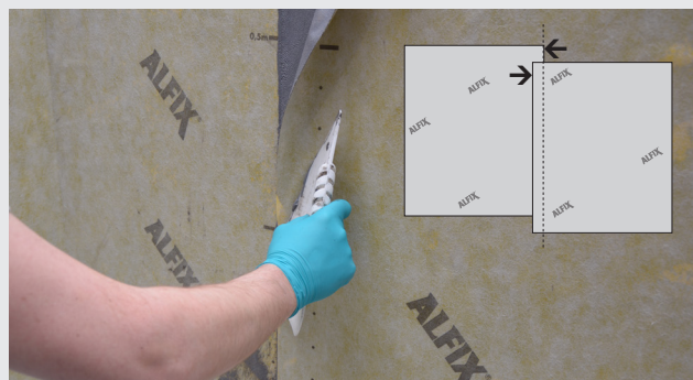
Montering av våd omlott vid skarv
