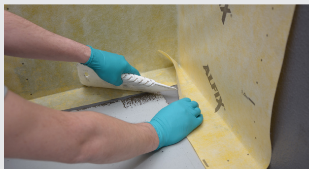
Montering av våtrumsmattan
