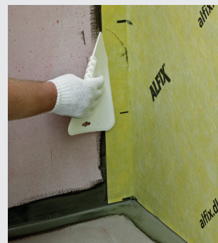
Montering av våd i hörn
