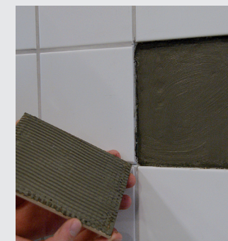
Tätningsmassan påförs underlaget och plattan monteras
