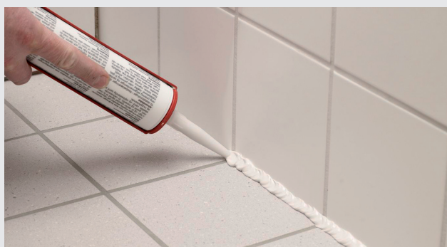
Påföring av Alfix Silicon så att hela fogen fylls
