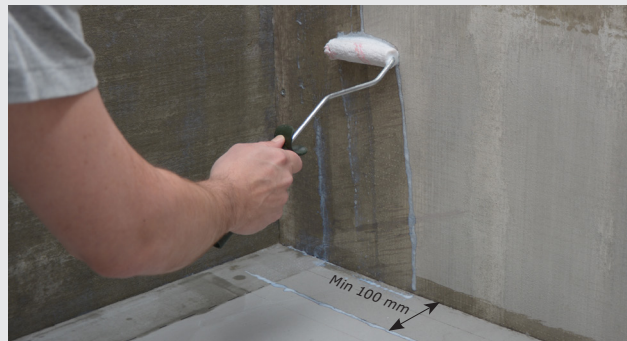
Reglering av underlagets sugförmåga
