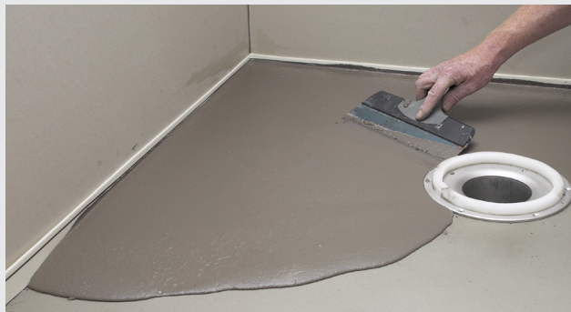
Golvlutning vid runda brunnar
