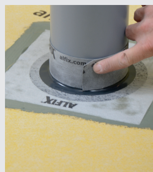
Förstärkning med Seal-Strip vid vattenbelastade rör
