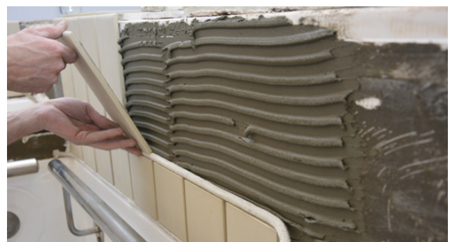
Montering av plattor
