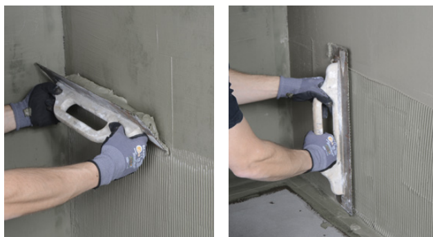
Applicering av 2K Tätningsmassa och glättning
