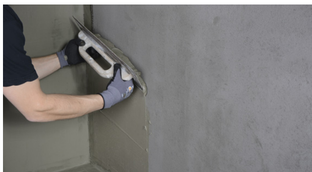
Applicering av Alfix 2K Tätningsmassa – porfyllande skikt
