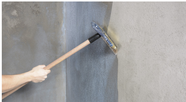
Primerbehandling med Alfix PlaneMixPrime
