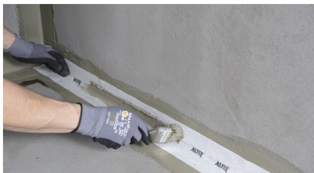
Montering av Alfix VT-tätningband
