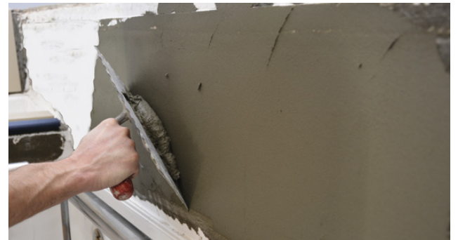
Applicering av kontaktskikt
