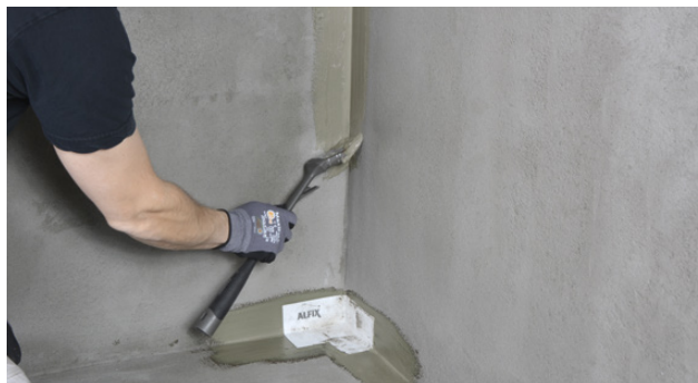
Montering av Alfix VT-hörn i tätningssmassa
