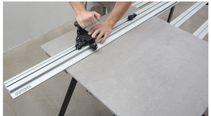
Opridsing av flise med styreskinne
