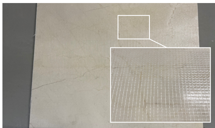
Flise belagt med epoksy-nettførsterkning
