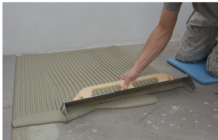
Påføring av flislim på underlaget
