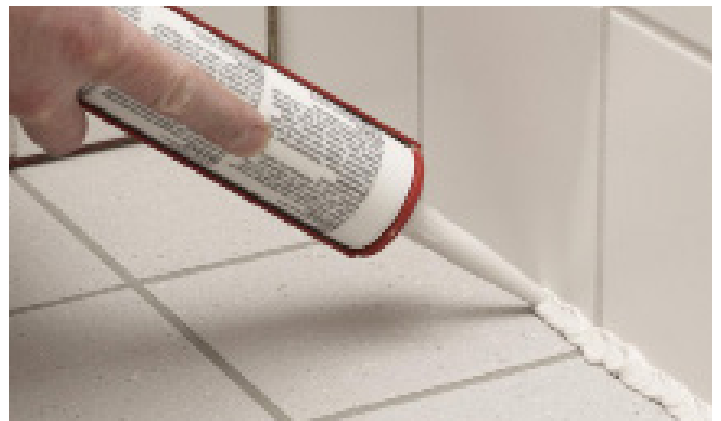
Påføring av silikonefugemasse
