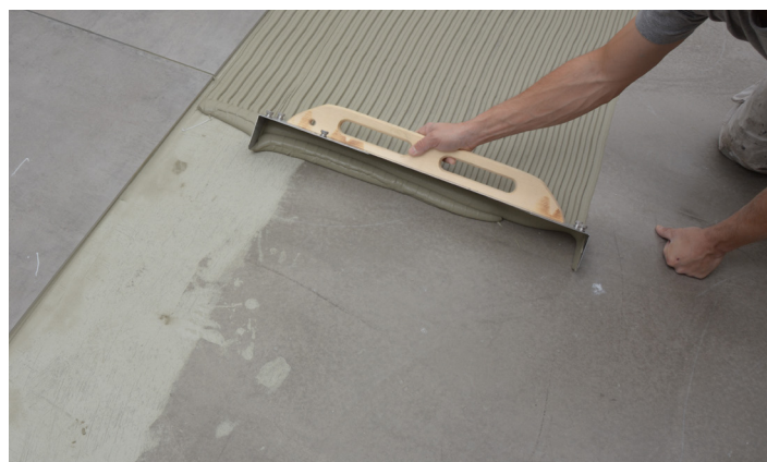
Flislim trekkes på underlaget
