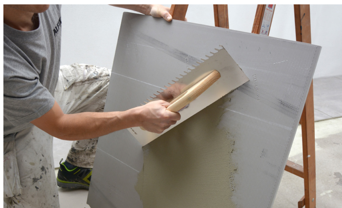
Påføring av flislim på flisens bakside
