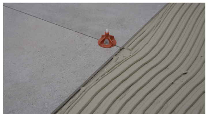
Eksempel på nivelleringsystem til fliser
