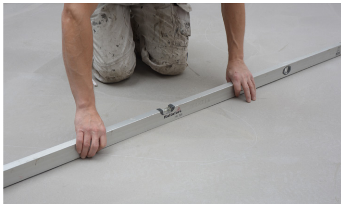
Kontroll av underlagets planhet
