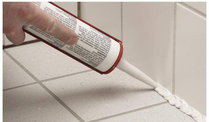
Påføring av silikonefugemasse
