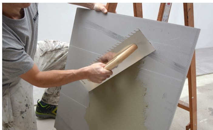
Påføring av flislim på flisens bakside
