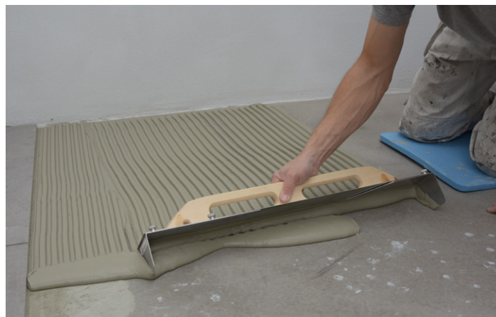
Påføring av flislim på underlaget
