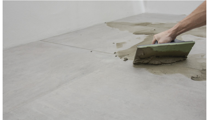
Påføring av fugemasse
