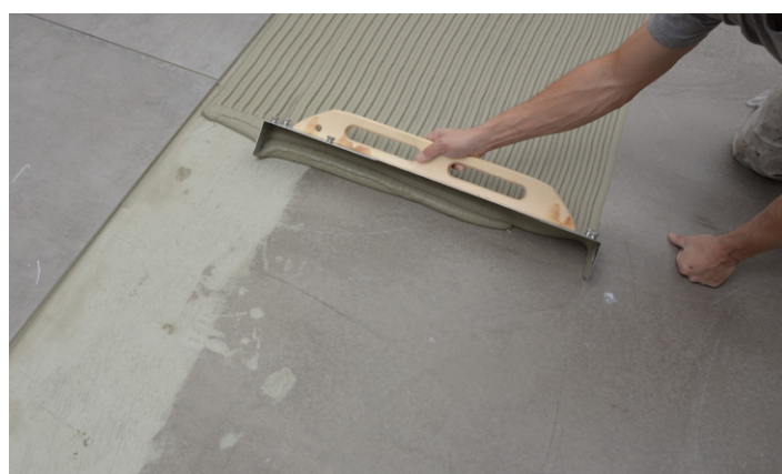
Flislim trekkes på underlaget
