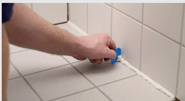
Overflødig fugemasse fjernes
