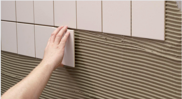
Montering av fliser på vegg
