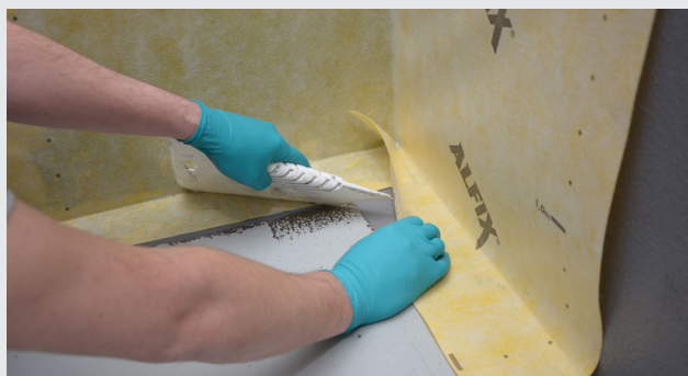
Metode 2: Montering av banemembranen
