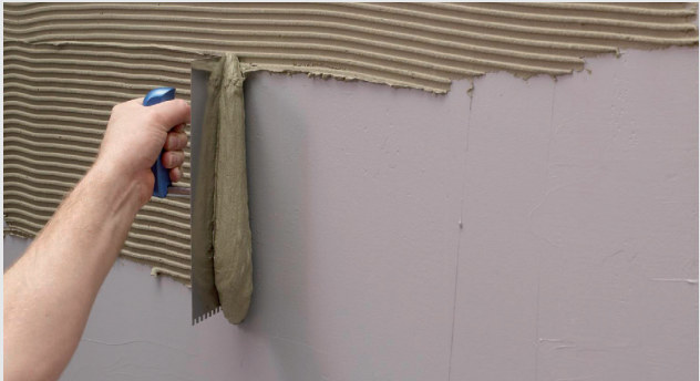
Påføring av flislim
