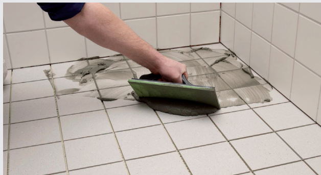
Påføring av sementbasert fugemasse
