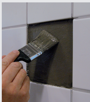
Tettningsmassen påføres underlaget, og flisen monteres
