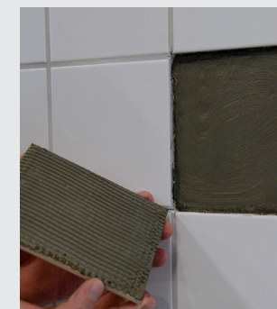
Tettningsmassen påføres underlaget, og flisen monteres
