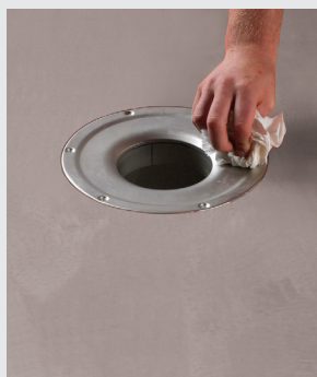
Rengjøring av slukflensen
