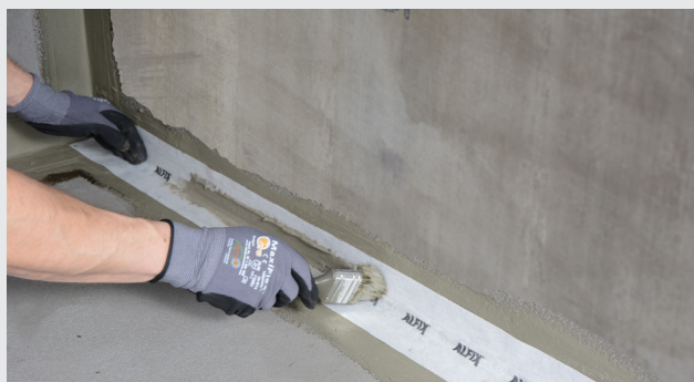
Metode 1: Montering av Alfix VT-tettningsbånd
