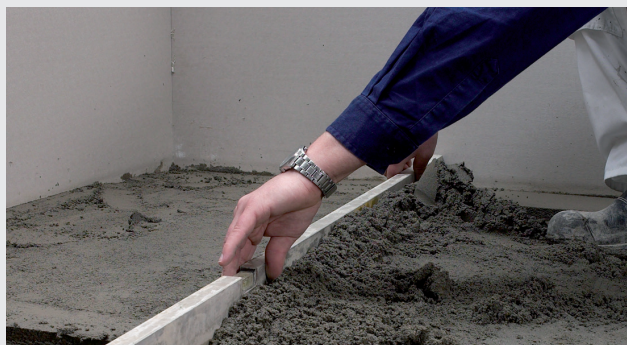
Støp på trebjelkelag
