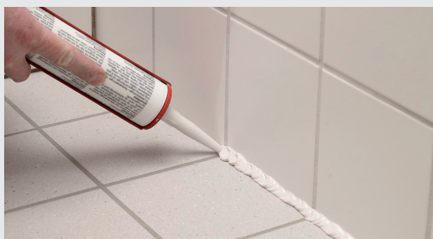
Fylling med silikonbasert fugemasse
