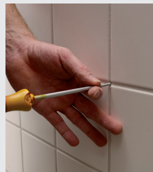
Montering av ekspansjonsplugg og montering av skrue
