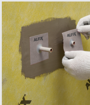
Montering av VT-rørmansjetter
