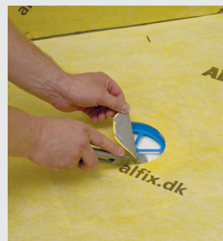
2: Utskjæring med skabelon ved slukmansjett Type H
