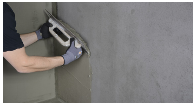
Påføring av Alfix 2K Tetningsmasse – porefyllende lag
