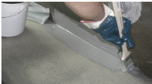
Påføring av Alfix Epoxy Membran
