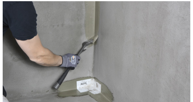
Montering av Alfix VT-hjørne i tetningsmasse
