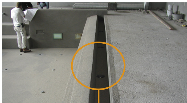
Montering av Alfix Tetningsbånd
