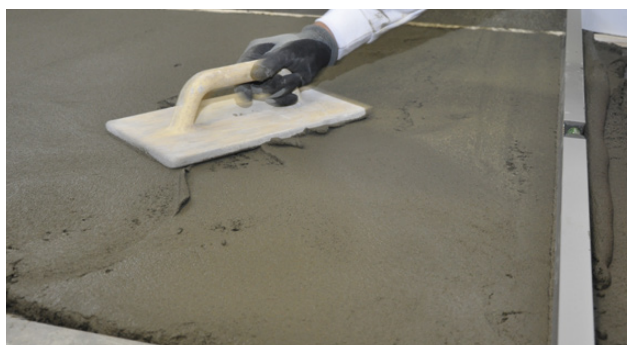
Bearbeiding med pussebrett
