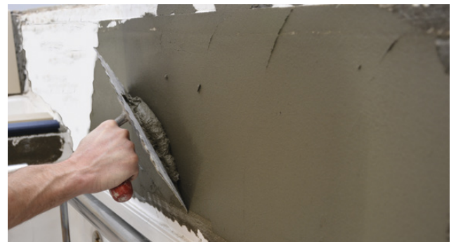
Påføring av kontaktlag
