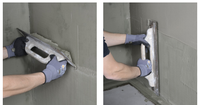
Påføring av 2K Tetningsmasse og glatting
