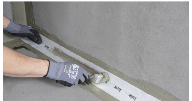
Montering av Alfix VT-tetningsbånd
