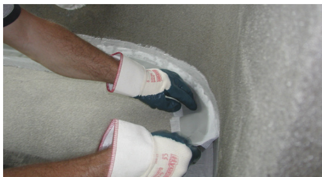
Montering av Alfix Tetningsbånd
