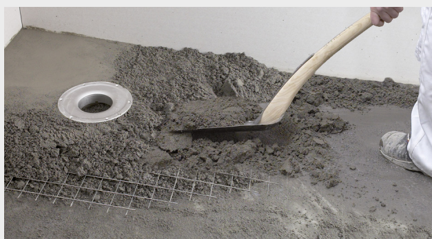
Opbygning af fald med støbemasse
