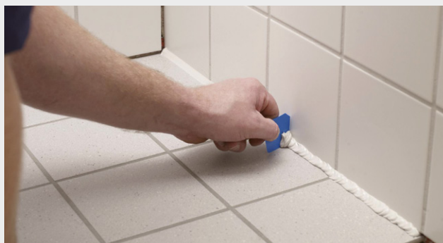
Overskydende fugemasse fjernes
