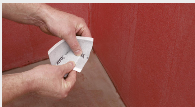
Tilpasning af selvklæbende hjørne
