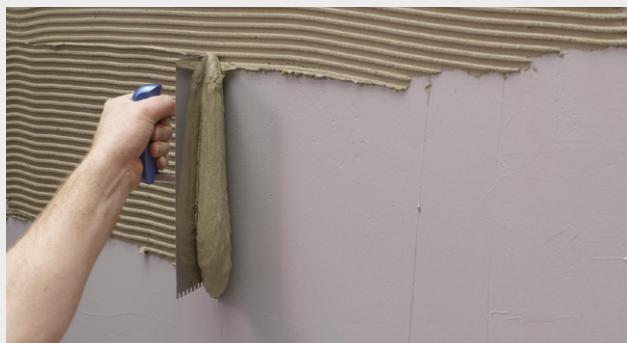
Påføring af fliseklæber
