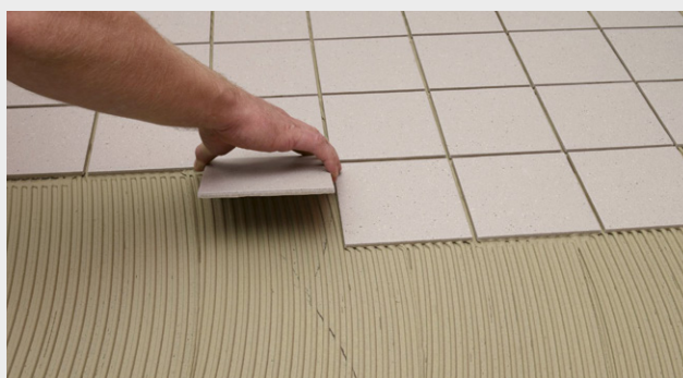
Montering på gulv
