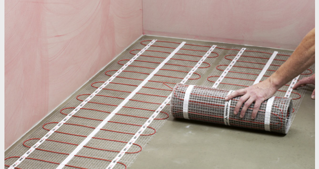
Udlægning af varmemåtter
