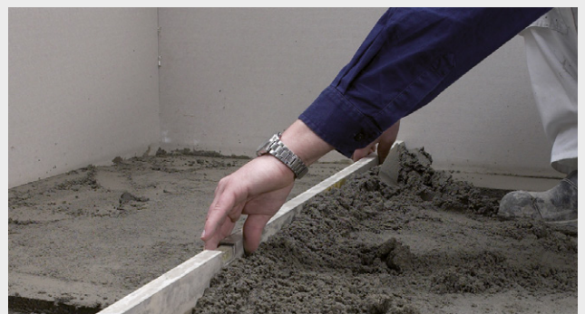
Udstøbning på træbjælkelag
