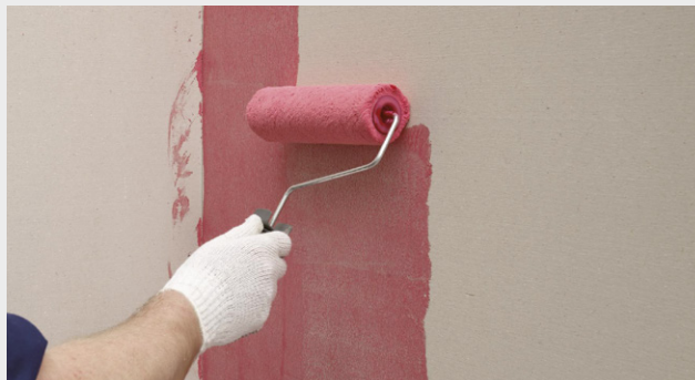
Primning på væg med rulle
