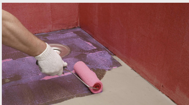
Primning på gulv med rulle
