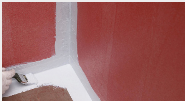
Påføring med pensel
