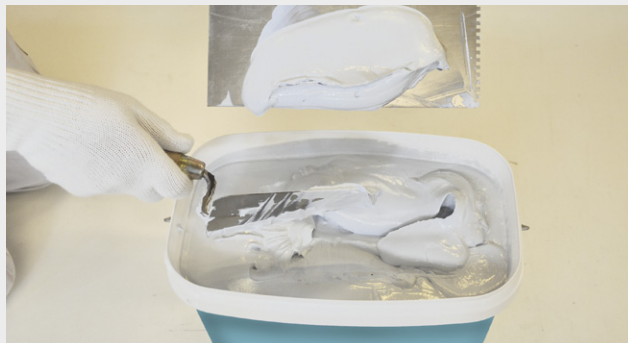
Tætningsmasse klar til påføring
