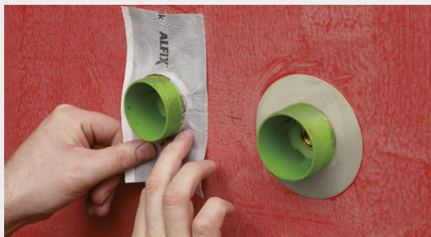
Montering ved rør
