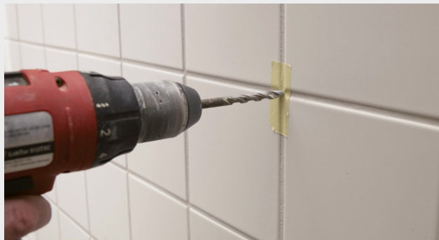
Boring af hul
