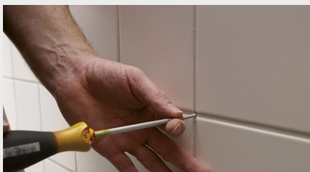
Montering af skrue efter fyldning med silikone
