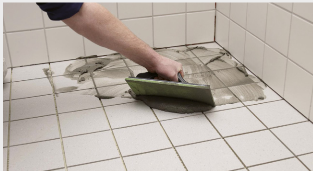
Påføring af cementbaseret fugemasse
