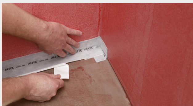
Montering i overgang væg og gulv
