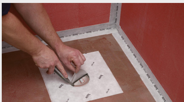
Markering og udskæring af hul
