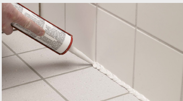
Fyldning med siliconebaseret fugemasse
