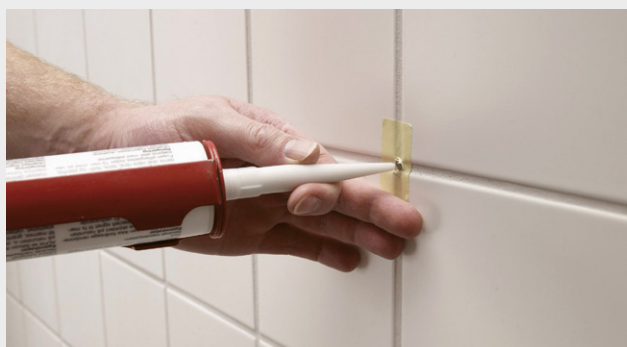
Fyldning af hullet med silikone
