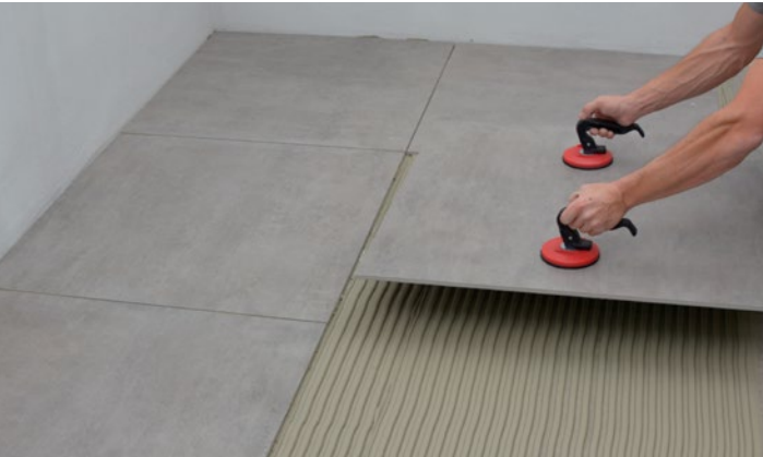
Montering af flise med sugekopper
