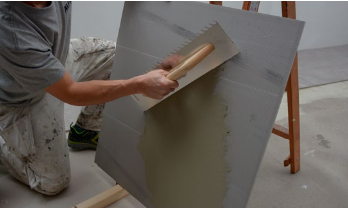
Fliseklæber påføres bagsiden af flisen (bagsmøring)
