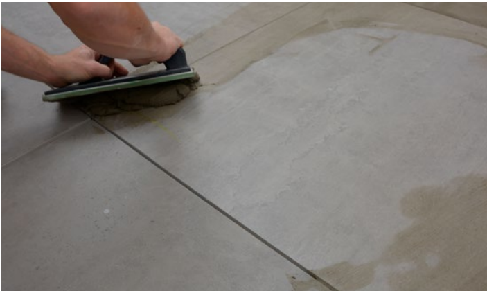
Påføring af fugemasse
