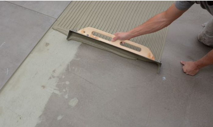
Fliseklæber trækkes på underlaget
