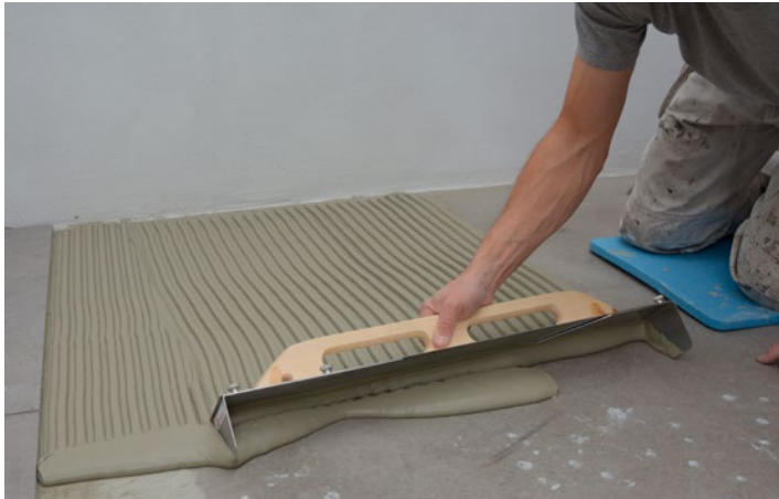
Påføring af fliseklæber på underlaget
