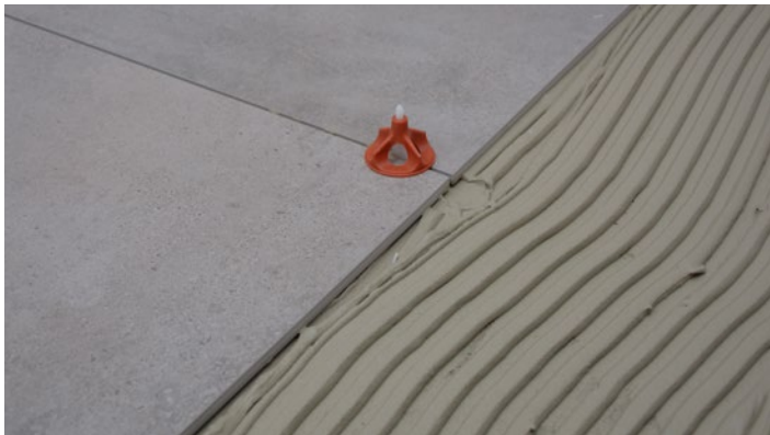
Eksempel på nivelleringsystem til fliser
