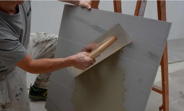
Påføring af fliseklæber på flisens bagside
