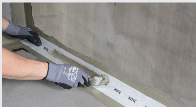
Metode 1: Montering af Alfix VT-Tætningsbånd
