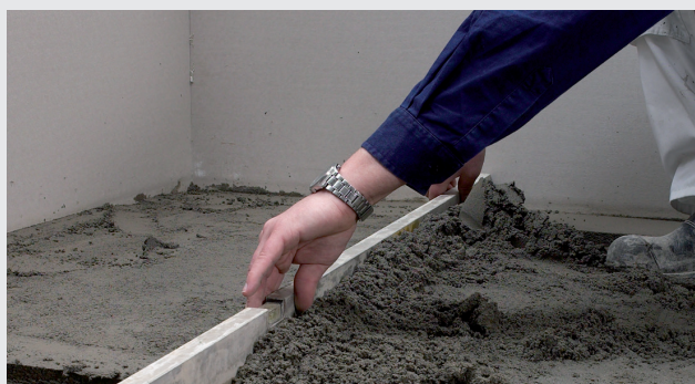
Støbning på træbjælkelag
