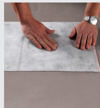
Montering af afløbsmanchet Seal-Mat 40x40 cm eller type H
