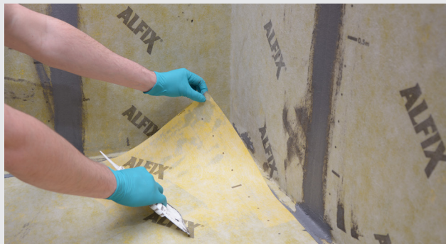
Montering af banemembran på gulv
