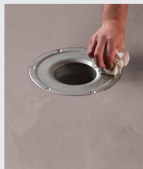
Rengøring af afløbets flange
