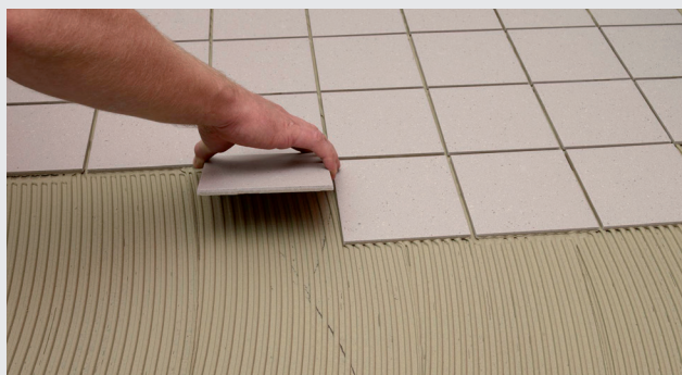
Montering af fliser på gulv
