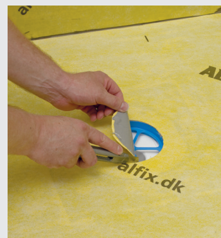
2: Udskæring med skabelon ved afløbsmanchet Type H
