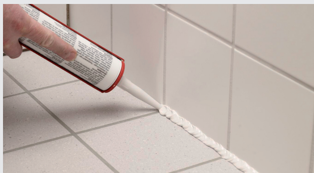
Fyldning med siliconebaseret fugemasse
