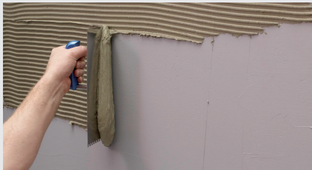
Påføring af fliseklæber
