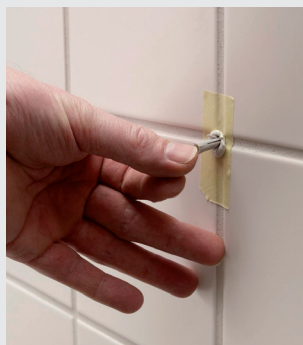
Montering af Rawlplug og montering af skrue
