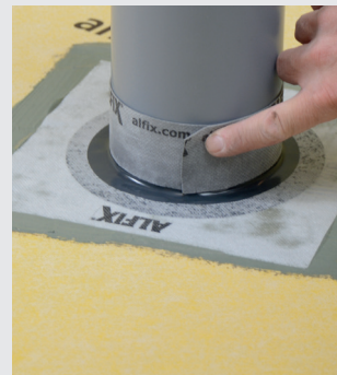
Forstærkning med Seal-Strip ved vandbelastede rør
