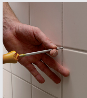
Montering af Rawlplug og montering af skrue
