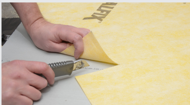
Metode 2: Skær 10 cm i væg-/vægsvinkel, hvor banemembranen monteres omkring hjørnet
