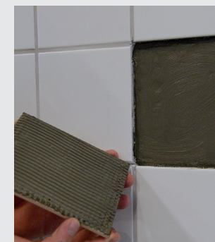
Tætningsmassen påføres underlaget, og flisen monteres
