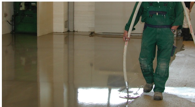
Udlægning med spartelpumpe
