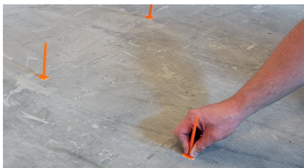
Markering med kotemål
