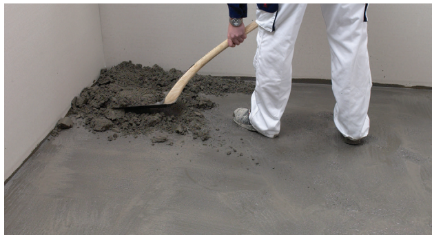
Støbemasse fordeles jævnt
