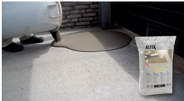
Udhældning af selvudflydende spartelmasse
