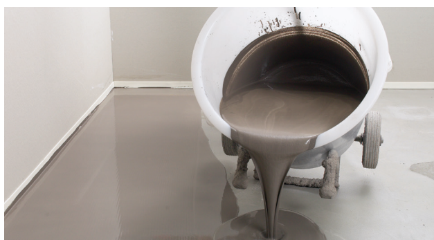
Udhældning af spartelmasse
