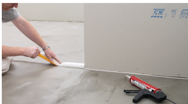
Afgrænsning med selvklæbende spartelstop
