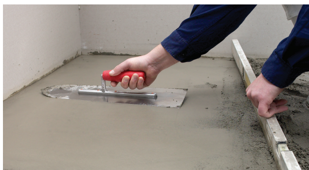
Støbemasse glattes ud med spartel
