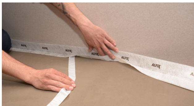
Montering af selvklæbende vægkantbånd
