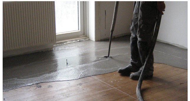
Spartling på træbjælkelag
