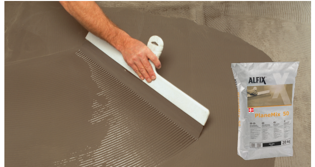
Fordeling af spartelmasse
