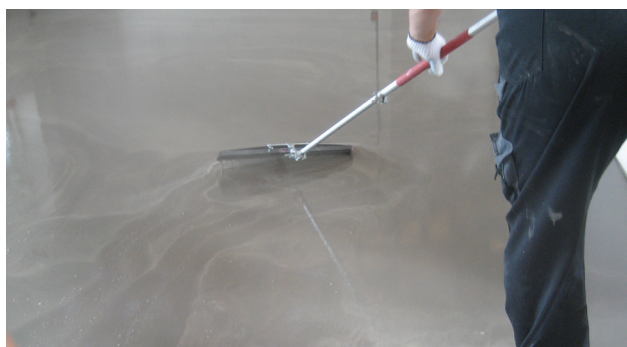
Fordeling af spartelmassen
