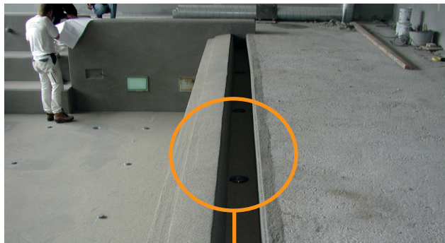
Montering af Alfix VT-Tætningsbånd
