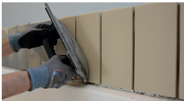
Påføring af Alfix IndustryFuge - CeraFill 18
