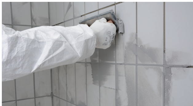
Påføring på væg med epoxyfugebræt
