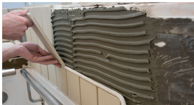
Montering af fliser
