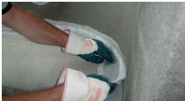
Montering af Alfix VT-Tætningsbånd
