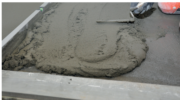
Udlægning og komprimering på gulv
