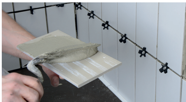
Påføring af skrabelag på flisens bagside
