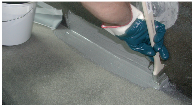
Påføring af Alfix Epoxy Membran
