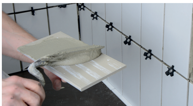
Påføring af skrabelæg på flisens bagside
