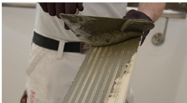
Påføring af skrabelag på flisens bagside
