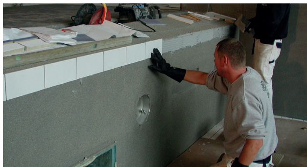
Montering af fliser i den fugtige klæber
