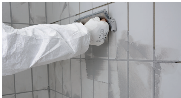
Påføring på væg med epoxyfugebræt
