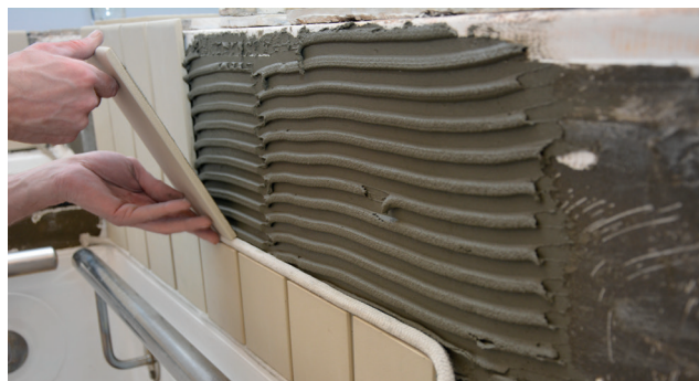
Montering af fliser
