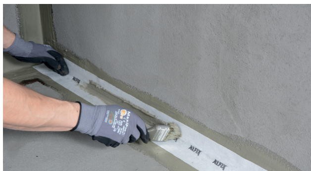
Montering af Alfix VT-tætningsbånd
