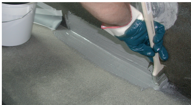
Påføring af Alfix Epoxy Membran
