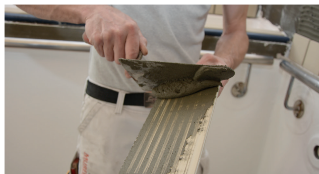
Påføring af skrabelag på flisens bagside
