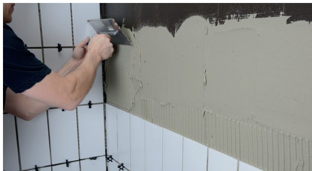
Påføring af fliseklæber med tandspartel
