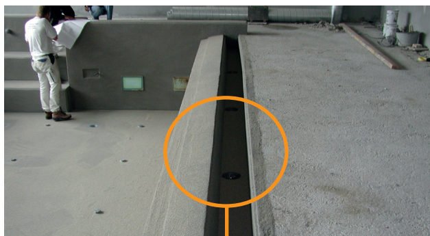
Montering af Alfix VT-Tætningsbånd
