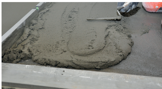
Udlægning og komprimering på gulv
