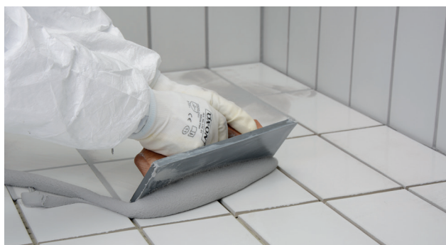
Påføring på gulv med epoxyfugebræt
