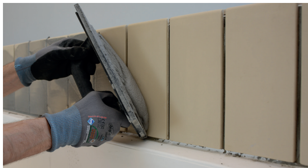
Påføring af Alfix IndustryFuge - CeraFill 18
