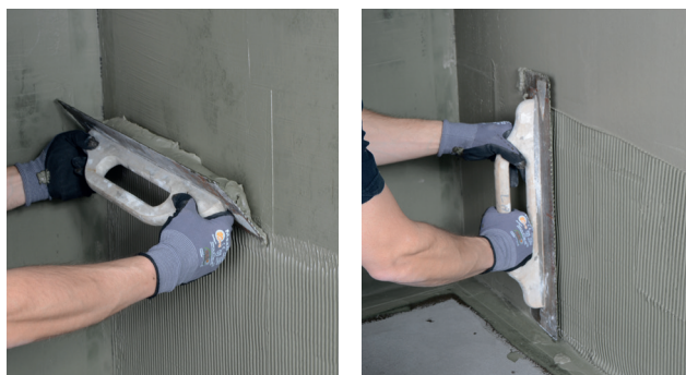
Påføring af 2K Tætningsmasse og glitning
