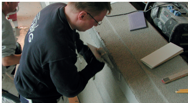
Påføring af Alfix EpoxyFuge 20 med tandspartel
