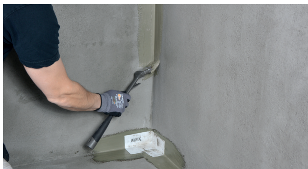
Montering af Alfix VT-hjørne i tætningsmasse
