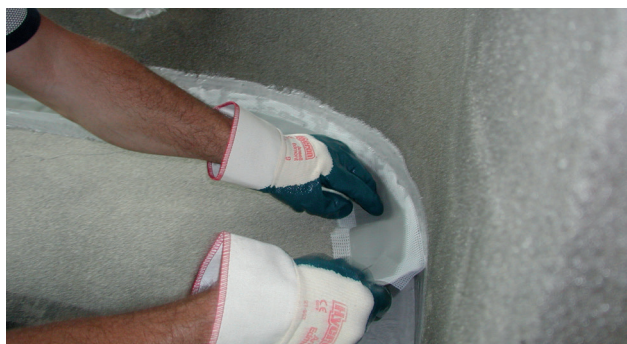
Montering af Alfix VT-Tætningsbånd
