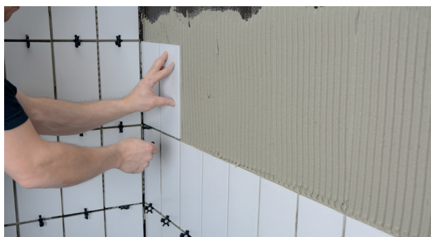
Montering af fliser
