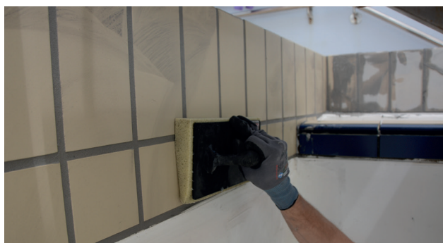
Fliserne afvaskes med hårdtopvredet viskosesvamp
