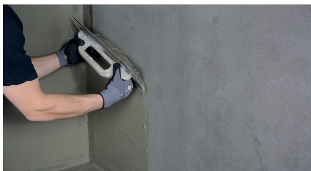
Påføring af Alfix 2K Tætningsmasse - porefyldende lag
