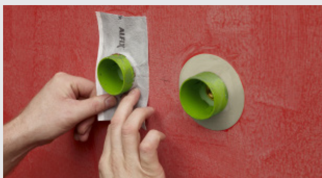
Montering ved rør
