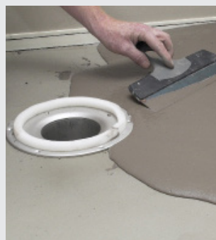
Opbygning af fald med spartelmasse, PlaneMix 60
