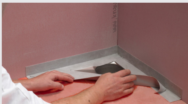
Montering ved designerafløb
