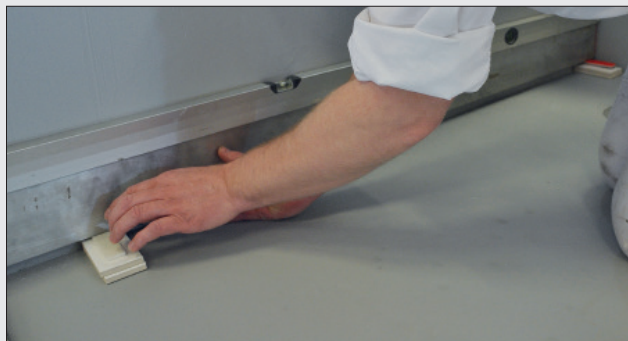
Markering af vandret linie med retskinne
