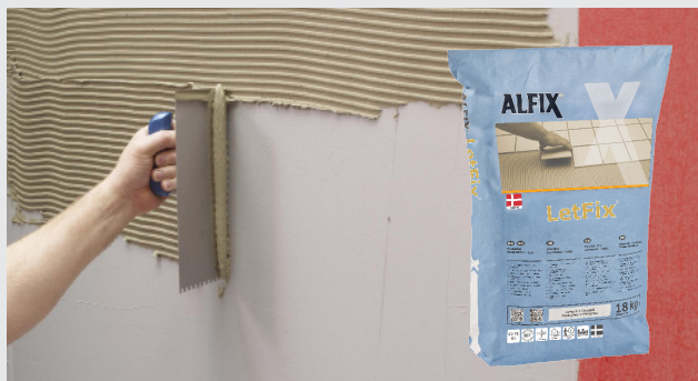
Påføring af fliseklæber, LetFix
