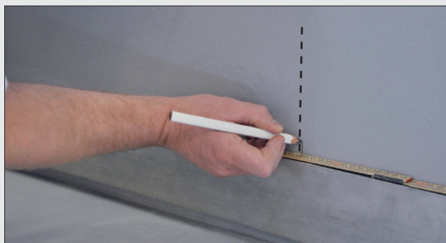
Afmærkning af væggens midtpunkt
