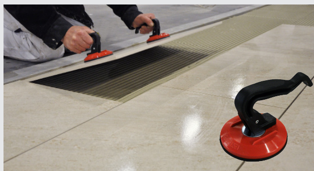
Lægning af fliser ved hjælp af sugekop
