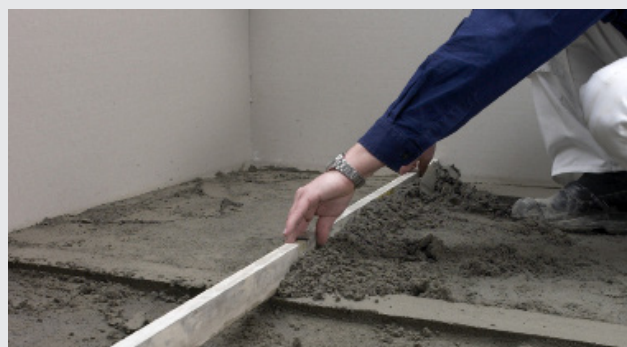
Afretning af overflade
