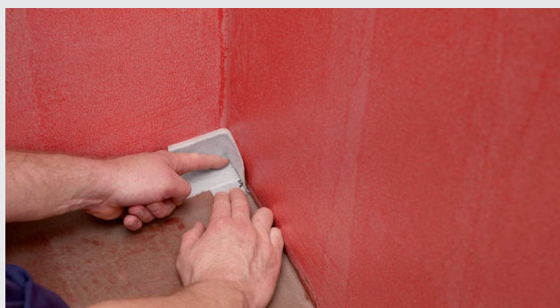
Montering af Seal-Strip i hjørne
