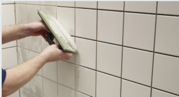
Påføring af cementbaseret fugemasse på væg
