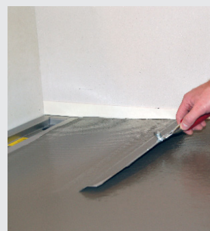
Opbygning af fald med spartelmasse, PlaneMix 60
