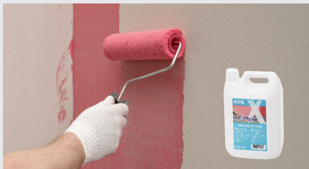
Primning på væg med rulle, VådrumsPrimer
