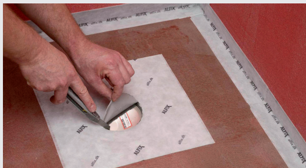
Markering og udskæring af hul
