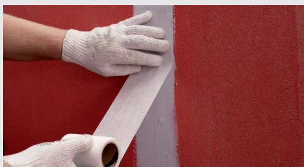
Forstærkning af samling med armeringsvæv
