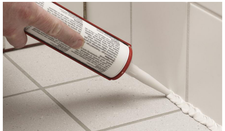
Påföring av M-Silicon så att hela fogen fylls
