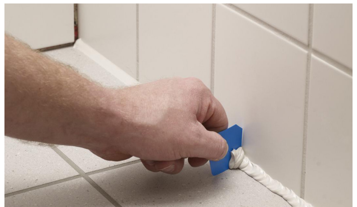
Överskjutande fogmassa skrapas bort
