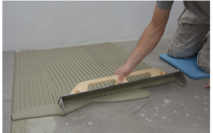
Applicering av fästmassa på underlaget
