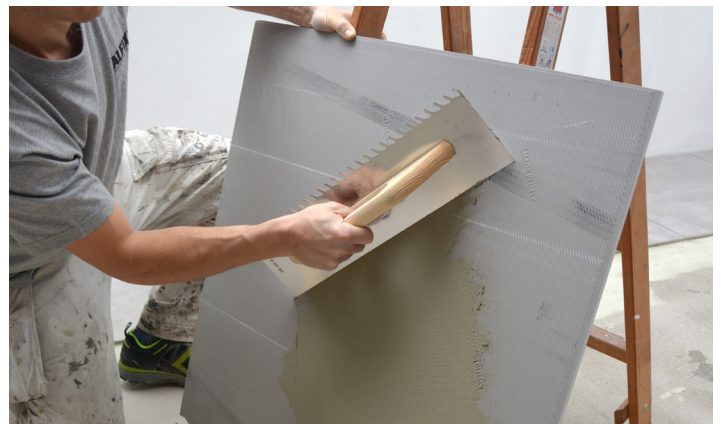
Applicering av fästmassa på plattans baksida (dubbellimning)
