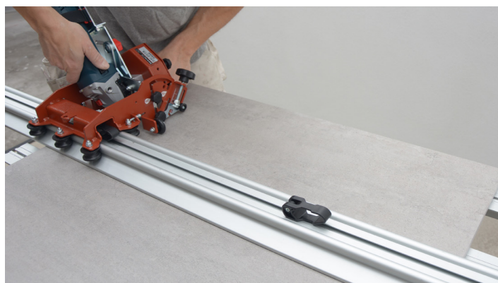
Skæring af flise efter styreskinne
