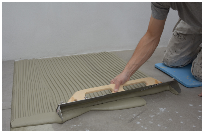
Påføring af fliseklæber på underlaget
