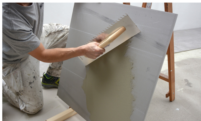
Fliseklæber påføres bagsiden af flisen (bagsmøring)
