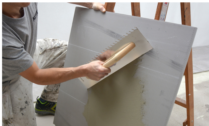
Påføring af fliseklæber på flisens bagside
