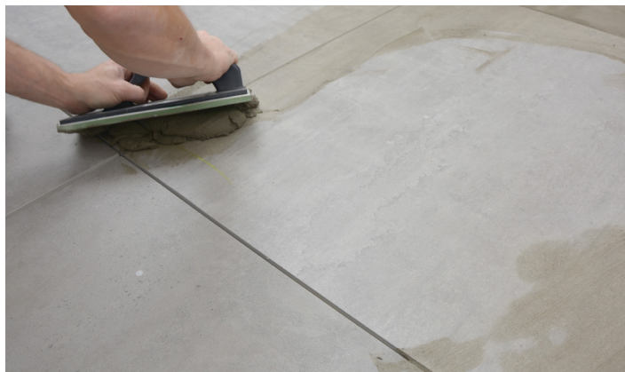
Påføring af fugemasse
