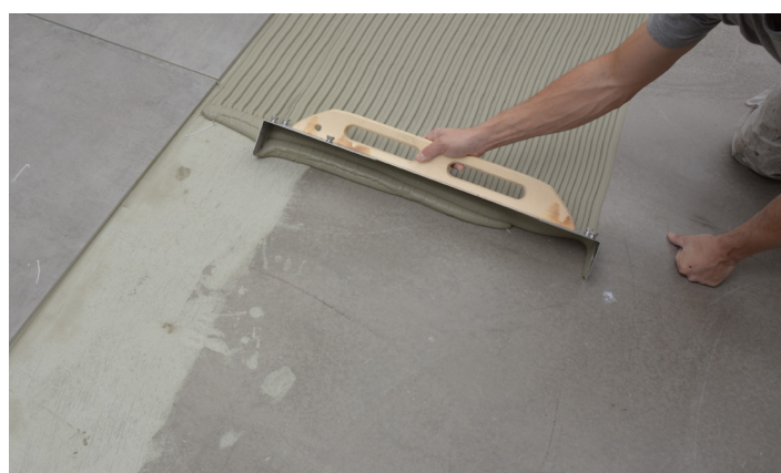
Fliseklæber trækkes på underlaget
